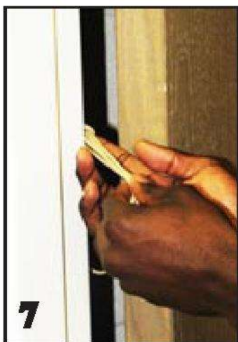
Pasos 7 & 8. Coloque el nudo de la cuerda en la bisagra de la puerta. Asegúrese de que el nudo esta detrás de la bisagra cuando la puerta está cerrada y que la cuerda permanece firmemente sujeta.
